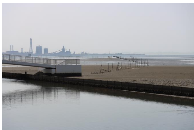
電柱撤去後の江川海岸
